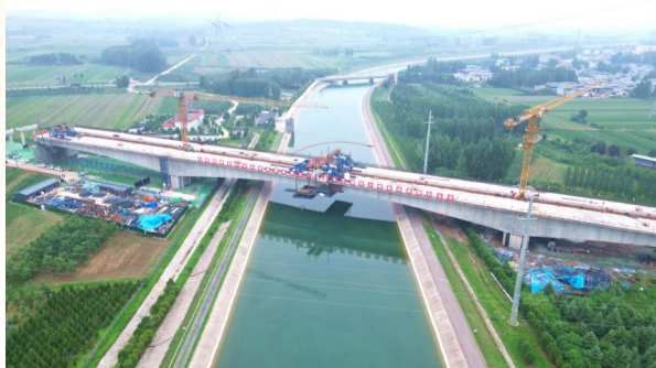
焦唐高速汝方项目南水北调特大桥 陶冶 摄
