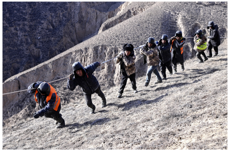
工人正在牵引导线作业
