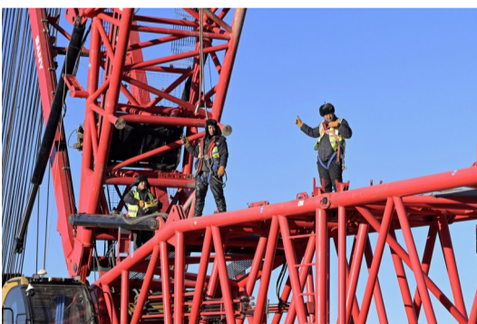
工人正在拼装履带吊车
