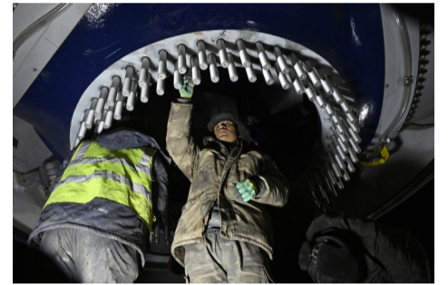
工人对风机叶片安装口位置进行复核
