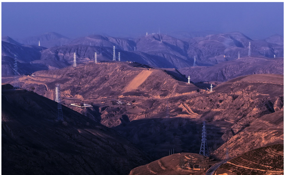
集电线路完成建设
