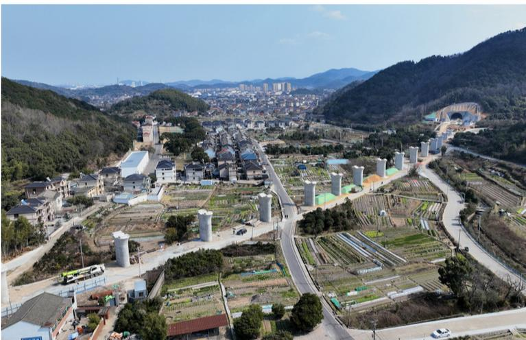
2月23日,中铁四局甬(宁波)舟(山)高速铁路六工区(二公司)施工的白泉村特大桥实体墩浇筑完成。甬舟高铁正线全长76.396公里,设计时速250公里,设7座车站。六工区管段长22.14公里,施工内容包含隧道、桥梁、路基、存车场等。其中,白泉村特大桥长0.53公里,设计实体墩16个。
