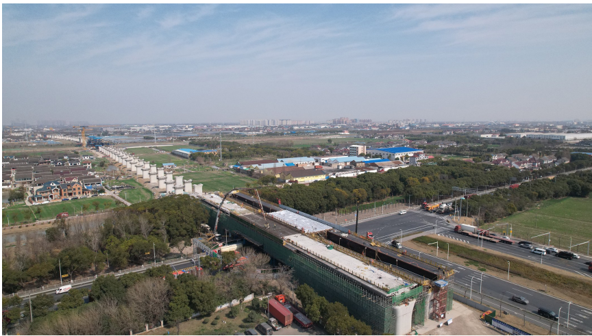
太徐特大桥跨宝钱路现浇连续梁浇筑完成
