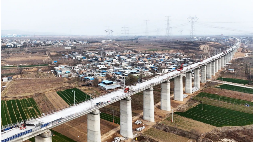
西延高铁2标富平特大桥箱梁架设完成
