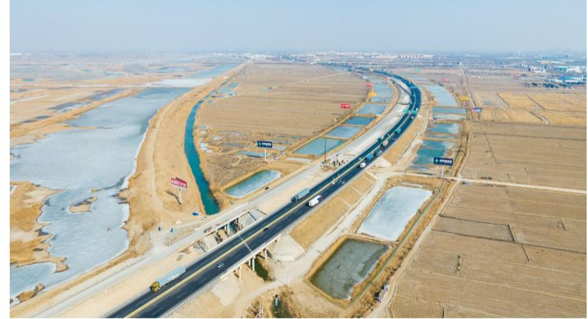
3月10日,在中铁四局五公司承建的(北)京哈(哈尔滨)高速公路沈山改扩建工程第九合同段施工现场,工程车辆来回穿梭,作业人员有序进行桥面“破旧革新”等作业,全面推进工程建设进度。该工程建设里程238公里,其中222公里采用双向10车道高速公路标准进行建设。其中,全长27.78公里的第九合同段由五公司主责、一公司、安装公司参建,施工内容包括路基、路面、桥梁、房建、交通安全设施和绿化等。
