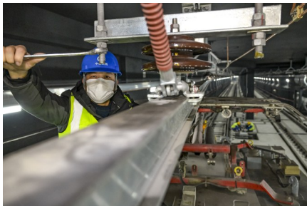
接触网工对接触网中心锚节进行精确复核
