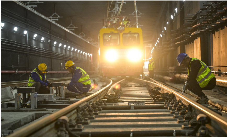
工作人员正在根据冷滑路径调整道岔并加锁轨器
