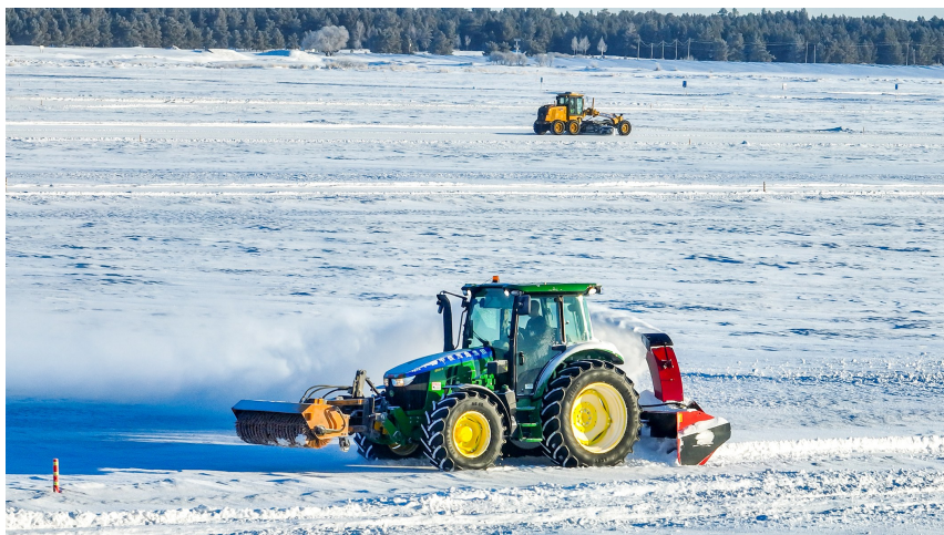
平地机和扫雪机正在进行场地修整作业
