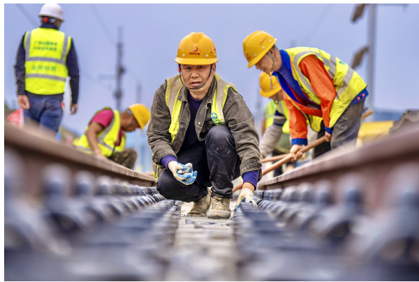
工作人员正在清理轨道散落道砟
