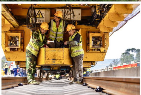
作业人员配合放置轨道配件螺栓
