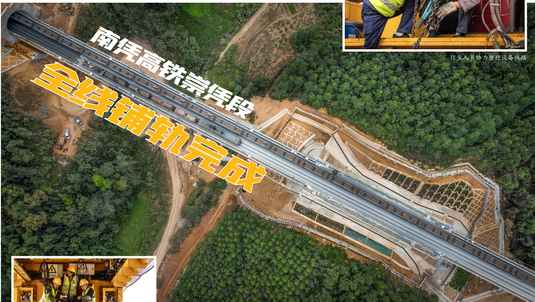
南凭高铁崇凭段铺轨作业现场
