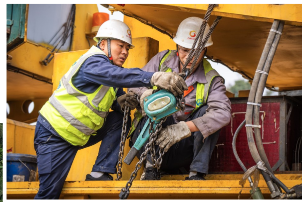
作业人员协力整理设备线路
