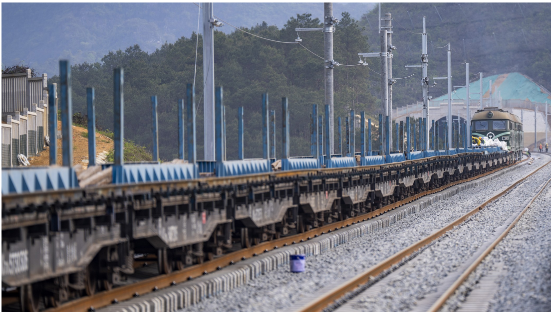
铺设整齐的轨枕
