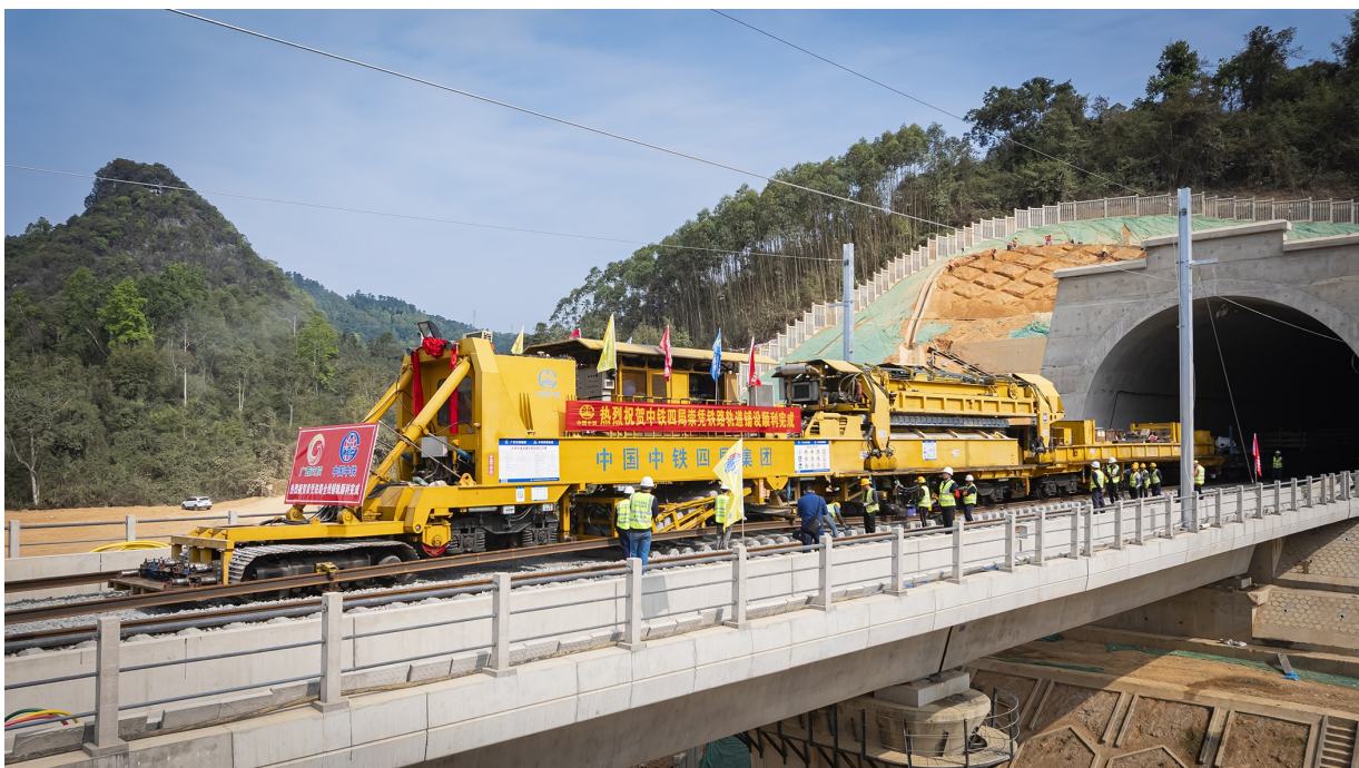
中铁四局自主研发的CPG500型钢轨机正在铺设轨枕
