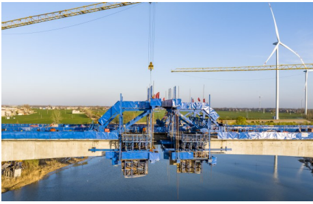
茨河特大桥14号块段连续梁施工
