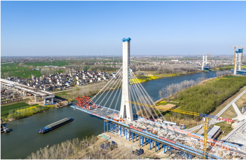
颍河特大桥主桥施工作业
