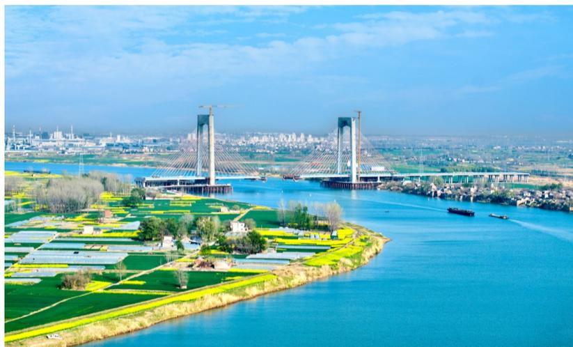
4月2日,在中铁四局一公司G329临淮关跨淮河特大桥项目施工现场,数百名建设者正抢抓春季施工黄金期,全力推动项目建设。该大桥是双塔双索面斜拉桥,桥长890米,塔高140.17米,主跨290米。主塔采用钟型设计,主梁运用混凝土边主梁+钢横梁+桥面板的新型组合形式,其钢横梁横宽达35.8米,刷新了同类梁型的记录,预计今年6月份主桥合龙。项目建成后,将推动淮河生态经济带国家战略的落地落地。
