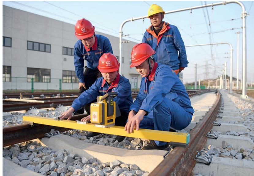
张飞(前排右一)指导新员工及产业工人激光测距仪的使用方法
