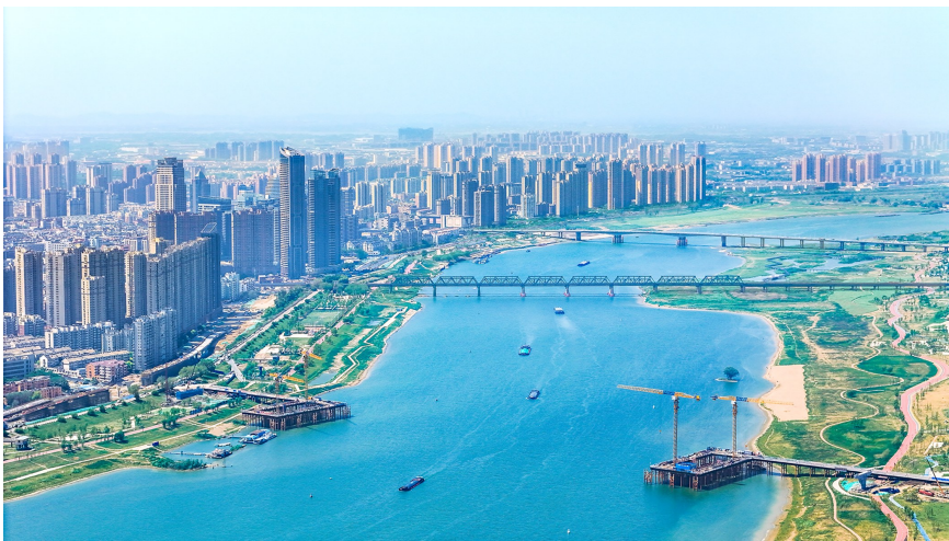
蚌埠延安路大桥主塔施工航拍
