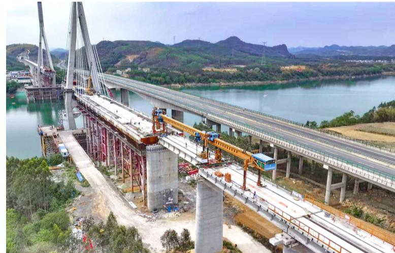
4月26日,中铁四局八分公司参建的柳(州)梧(州)铁路柳州方向架梁完成。柳梧铁路正线全长237.8公里,设10座车站,设计时速160公里。八分公司承担2228片T梁的预制架设任务,柳州方向黄茆特大桥至盘龙柳江特大桥架设T梁1564片。架梁前,项目部对架桥机、运梁车等设备进行全面检查,确保性能稳定。架梁过程中,项目部采用“分段架设、动态调整”的方案,合理调配人员和机械设备,确保T梁运输与架设无缝衔接,并针对桥梁分布密集的特点,优化架梁顺序。作业时设置专职安全员全程盯控,重点防范高空坠落、机械伤害等风险。此外,定期开展安全培训和应急演练,提升全员安全意识与应急处置能力,为T梁架设顺利推进奠定基础。
