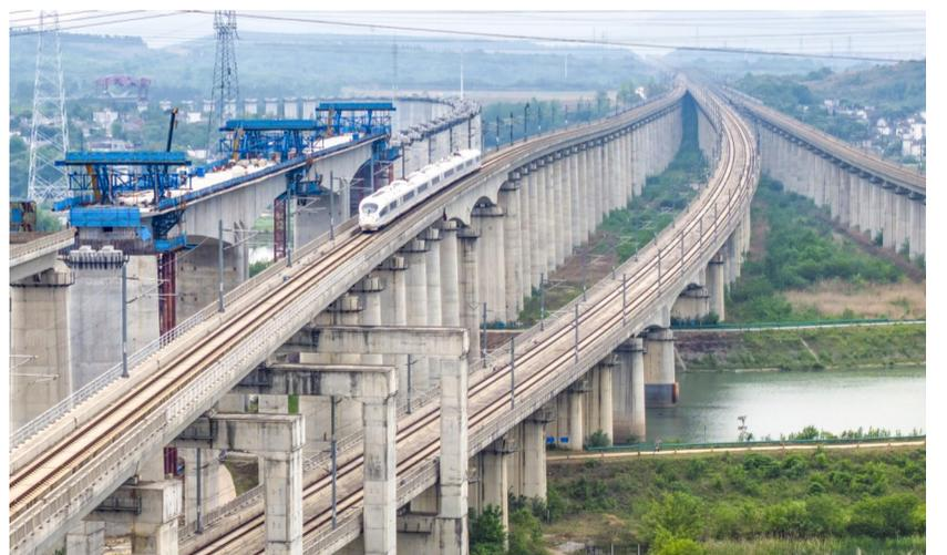
4月24日,在中铁四局承建的巢(湖)马(鞍山)城际铁路清溪河特大桥施工现场,作业人员正在进行连续梁最后一个节段吊装和钢筋焊接等工序施工。巢马城际全长73.2公里,设计最高时速350公里,设5座车站。其中,清溪河特大桥是巢马城际的控制性工程,施工难度大,技术要求高。目前,该桥的下部结构已全部完成,正处于上部结构施工阶段,预计5月中旬实现合龙。
