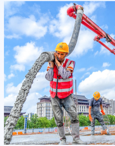
中铁四局南方总部项目住宅楼顶板浇筑 沈嘉鹏摄
