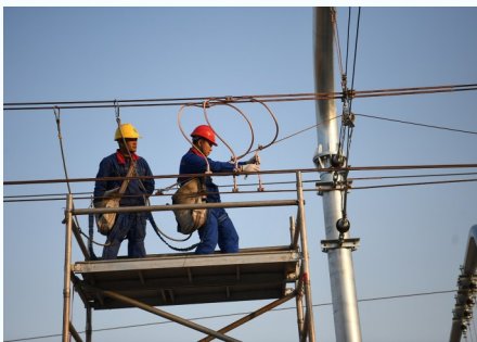
张飞(右一)与同事对接网设备进行安装调试
