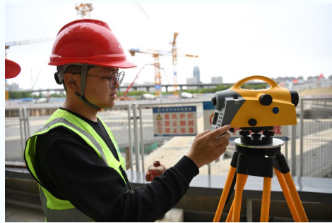
曾庆春在现场测量作业
