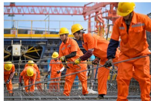
工人正在进行箱梁底板钢筋绑扎作业
