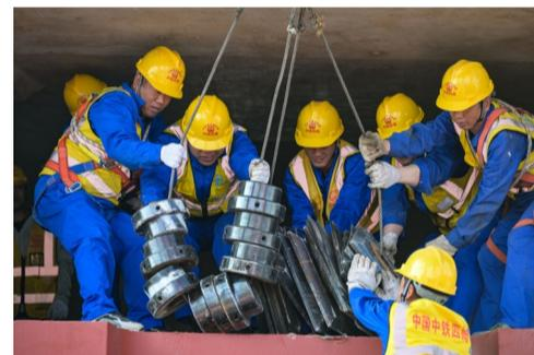
工人正在进行箱梁吊具安装
