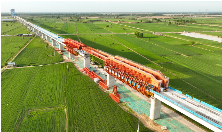
京雄商高铁黄河特大桥移动模架
