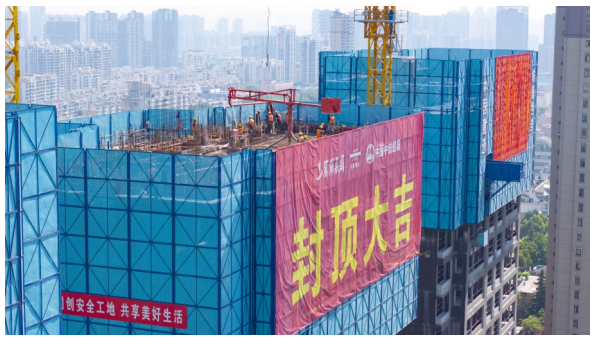
合肥市包河区卫岗TOD工程总承包项目B区封顶 刘创辉 摄
