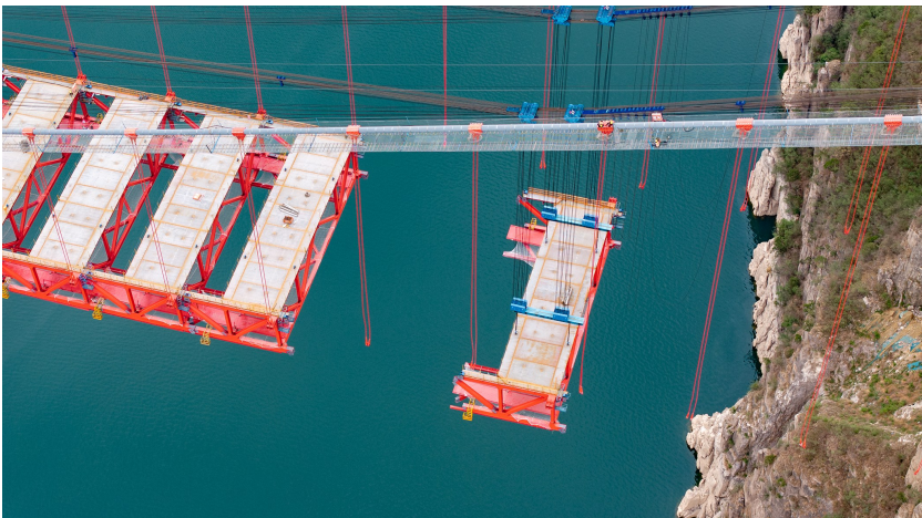
钢桁梁架设施工有序推进
