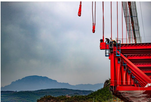
工人正在进行钢梁与吊索连接作业
