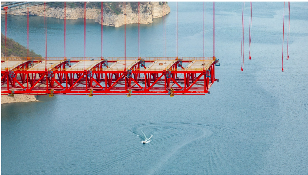
济新高速公路黄河大桥钢桁梁架设施工现场
