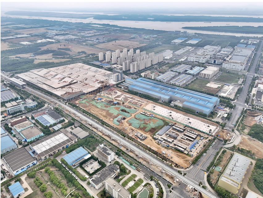
宁马城际滨江车辆段主体结构施工
