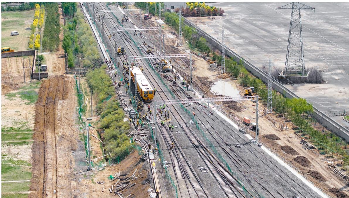
捣固车对道砟进行高频振动捣固
