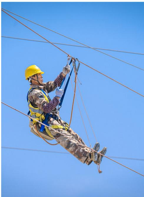
作业人员正在架设铁路接触网
