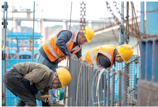
工人正在铜钵河特大桥现场绑扎钢筋
