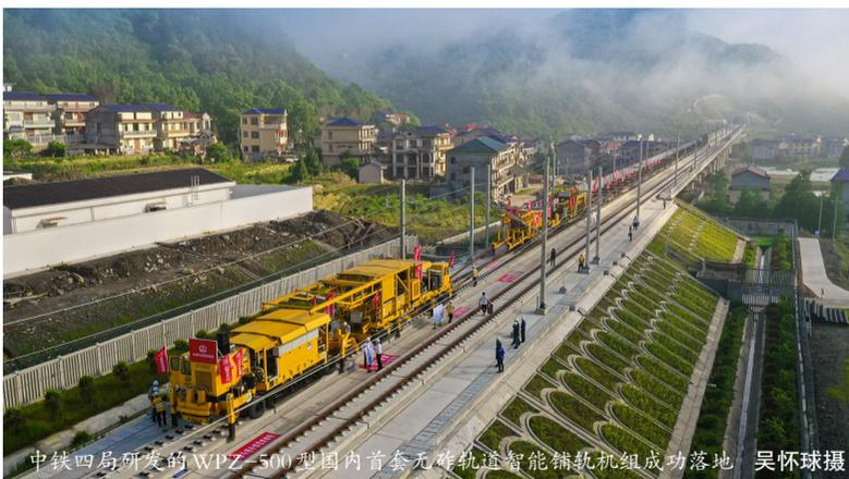
中铁四局研发的WPZ-500型国内首套无砟轨道智能铺轨机组成功落地 吴怀球摄
