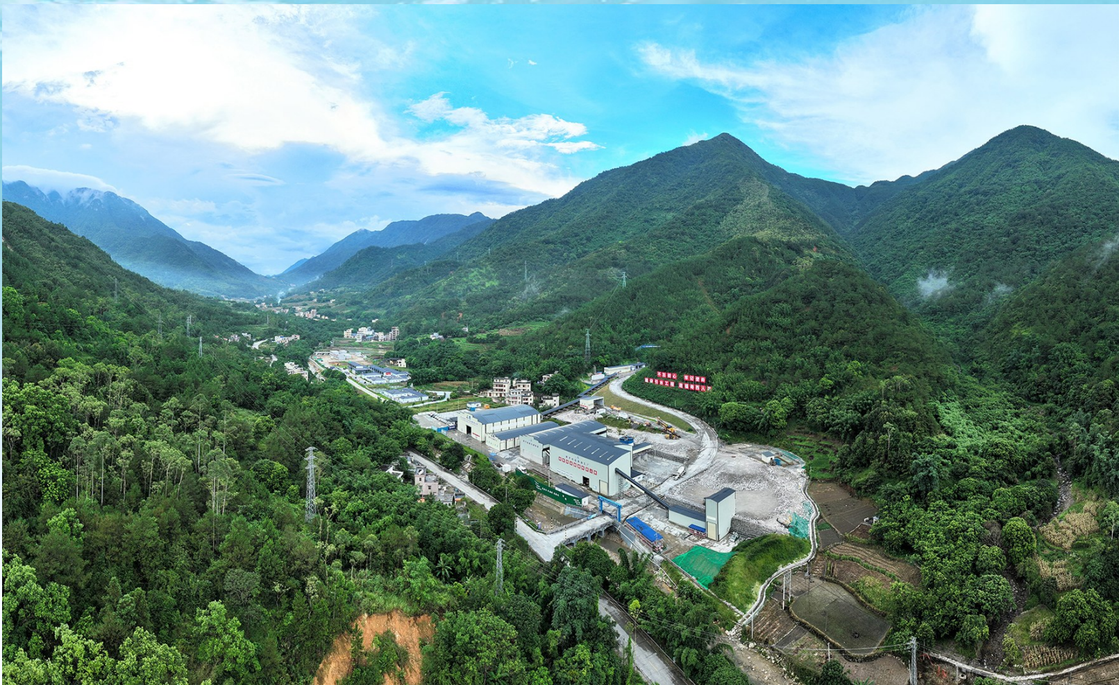
贵子支洞工区航拍
