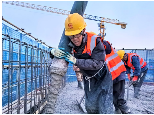
工人在进行顶板混凝土浇筑
