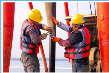
工人正在对浆泵管进行绑扎维护
