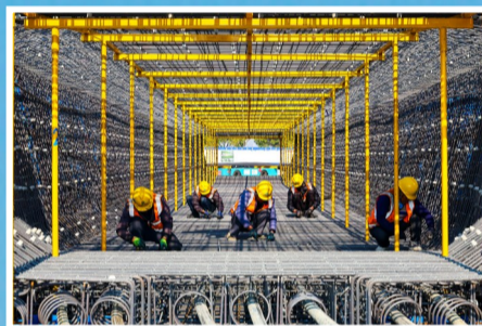
工人正在进行箱底板钢筋绑扎
