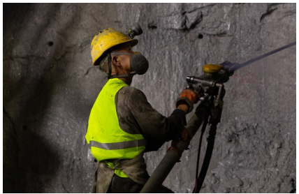
工人正在进行钻孔作业 鲁颖 摄
