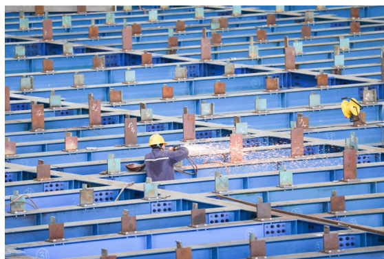
工人正在进行钢箱梁总体拼装胎架标高精调施工
