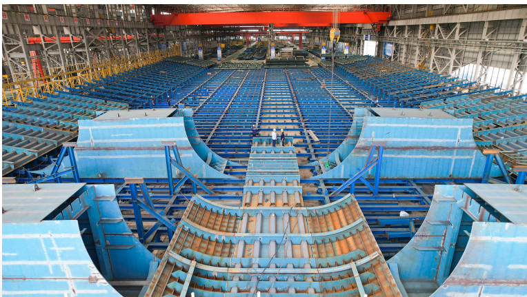
钢箱梁总体拼装现场
