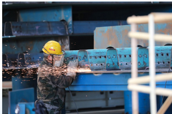
工人正在进行大桥顶底板单元U肋打磨作业
