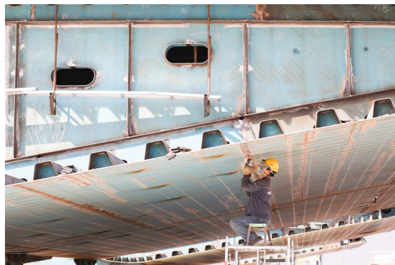
工人正在进行焊缝打磨作业
