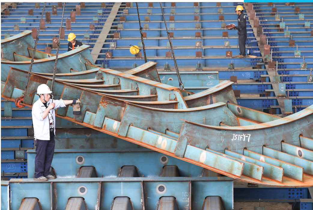
作业人员正在指挥钢箱梁拼装
