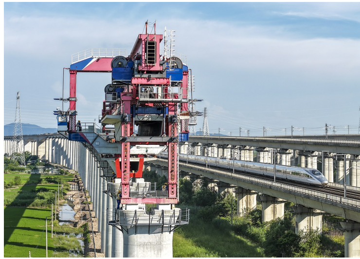
高铁列车从巢马城际铁路架梁现场飞驰而过
