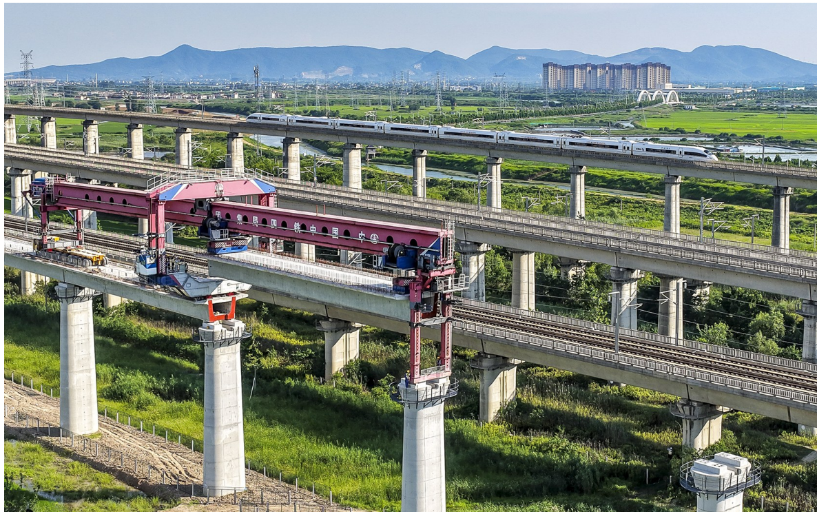
巢马城际铁路架梁稳步推进
