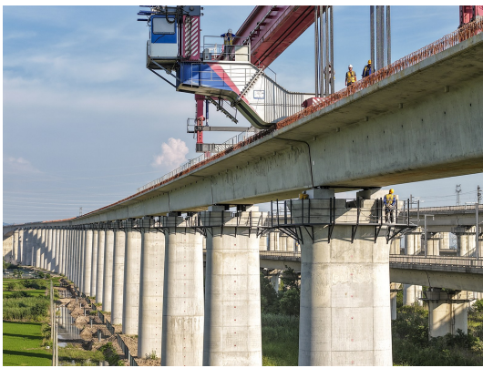
一孔箱梁稳稳地落在桥墩上
