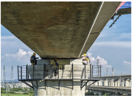
工人正在进行落梁后的收尾工作
