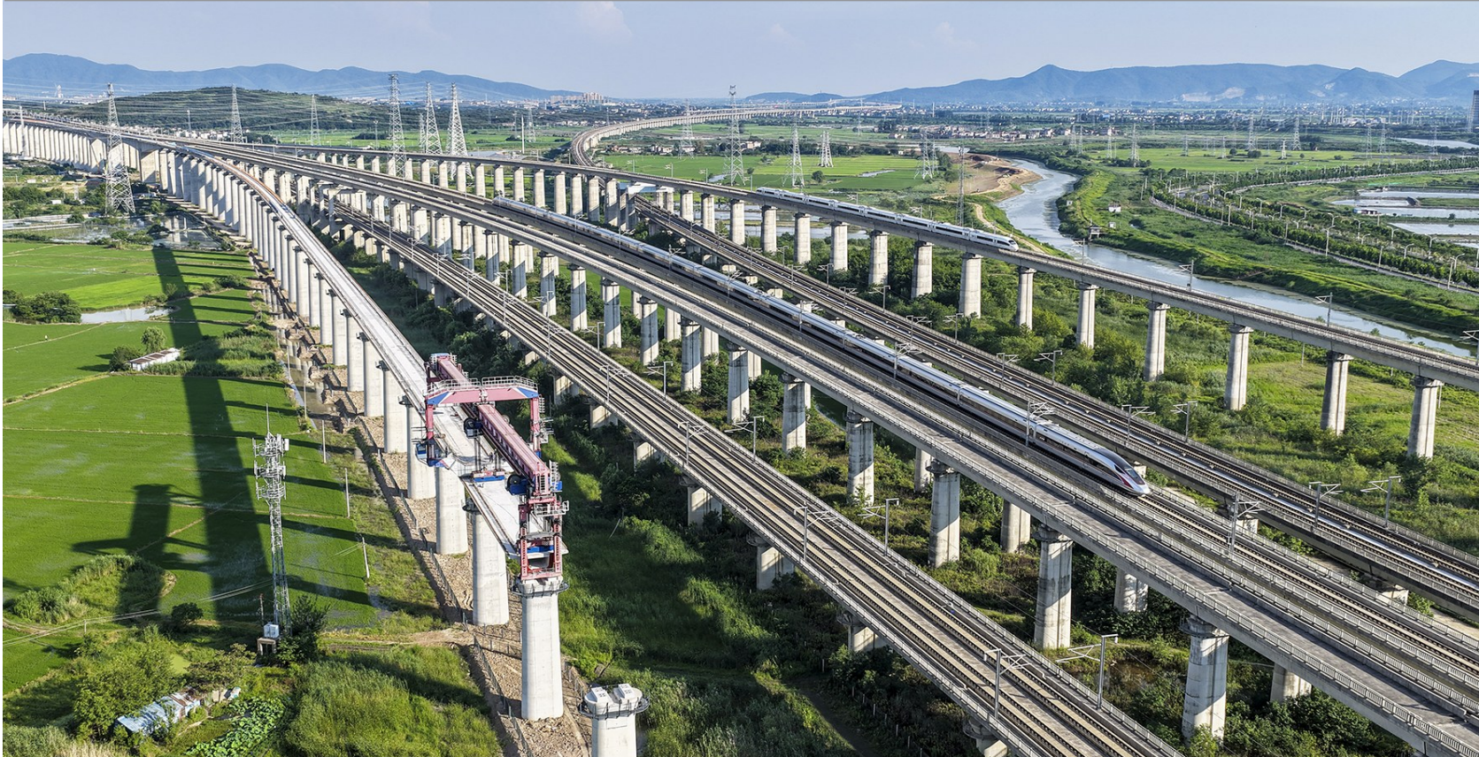
建设中的巢马城际铁路
