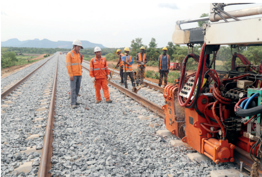
工人正在进行铺轨作业
