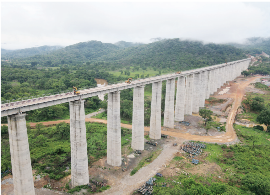
马西铁路铺轨施工作业现场
