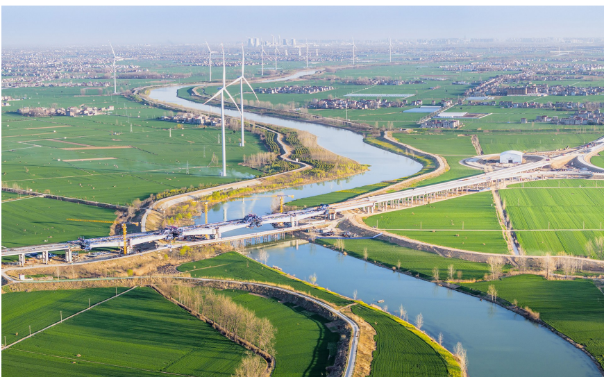
徐淮阜高速公路茨河特大桥连续梁节段施工
