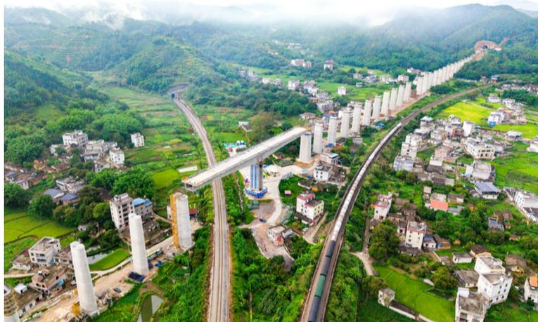
7月2日,中铁四局五公司承建的南(宁)珠(海)高速铁路玉林至岑溪段义村村跨益湛铁路特大桥连续T构转体完成,标志着南珠高铁玉岑段全线2处连续T构转体桥转体施工全部完成。南珠高铁玉岑段正线全长110.04公里,设计时速350公里,设3座车站。义村村跨益湛铁路特大桥长1.334公里,采用(80+80)米连续T构上跨益湛铁路,转体高度约40米,总重量达14000吨。为不影响益湛铁路正常通行,项目部采取“先建后转”的方法,在该桥平行于益湛铁路一侧采用挂篮悬臂现浇法预先施工转体桥T构部分,继而使用转体牵引系统进行转体施工。
