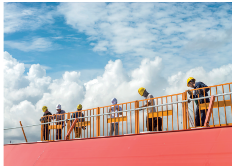
工人正在安装钢箱梁护栏
