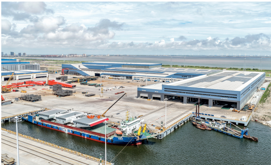
首段钢箱梁装船完成
