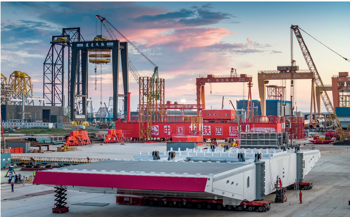
西堠门大桥金塘岛侧首段钢箱梁发运现场
