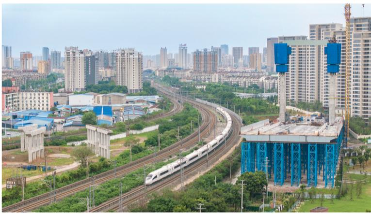
7月12日,中铁四局四公司承建的合肥市淮南路涉铁项目主桥索塔上横梁吊装。该主桥长661.5米,施工内容包括桥梁、道路、照明等,其中高架桥梁长518米,主桥设计为独塔双索面钢箱梁斜拉桥。
