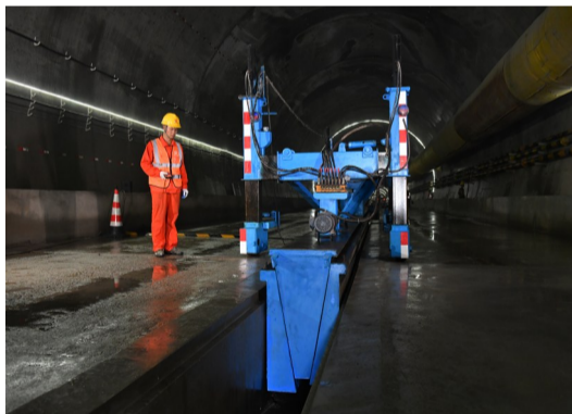
王昊摄 工人正在操作中心水沟台车施工作业
