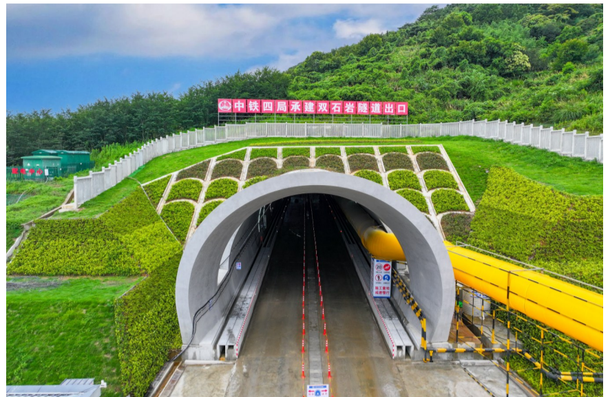
双石岩隧道出口
