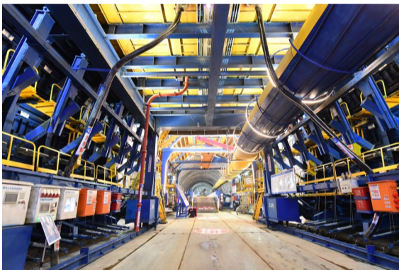
衬砌台车正在双石岩隧道中施工作业
