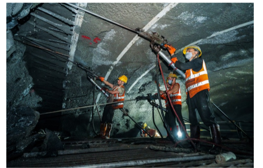
工人在六丰顶隧道进行锚杆施工作业 沈嘉鹏摄
