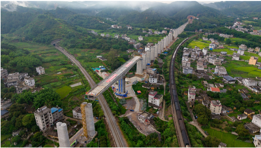
南珠高铁玉岑段3标义桐村跨益湛铁路特大桥连续T构转体 李小艳摄
