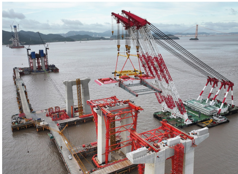
甬舟铁路西堠门公铁两用大桥2号墩主梁架设吊装作业
