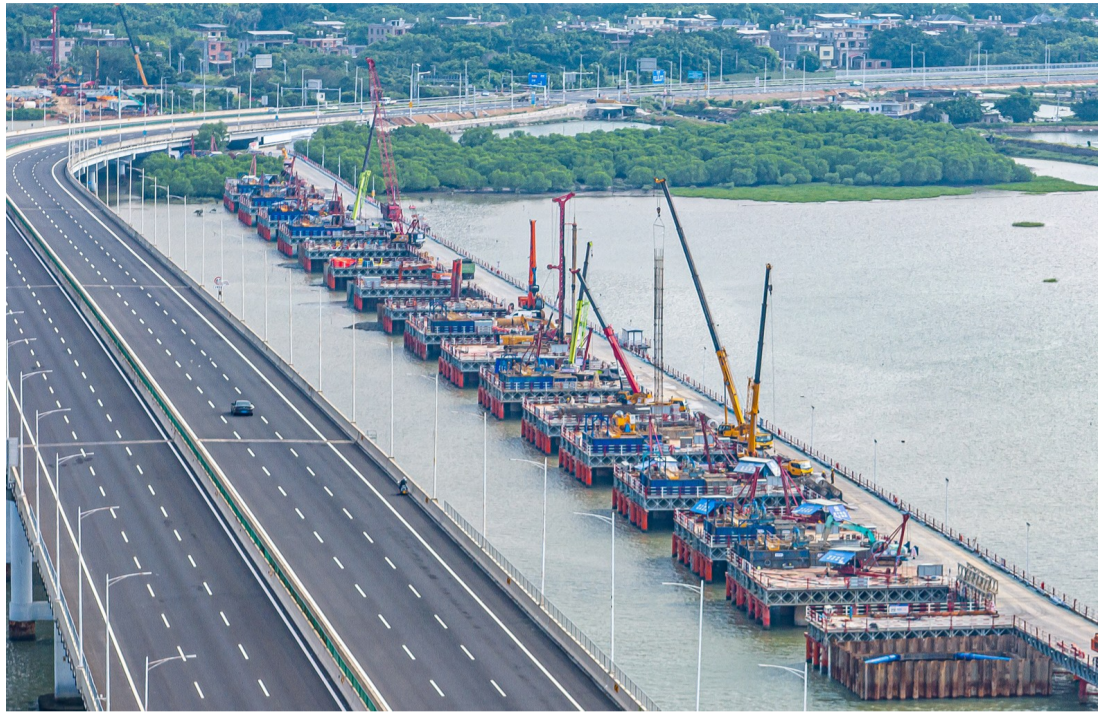
钢铁巨臂林立,海上桩基建设有序推进
