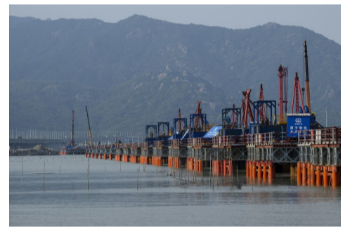
“海上搭积木”,开启高效建造新模式
