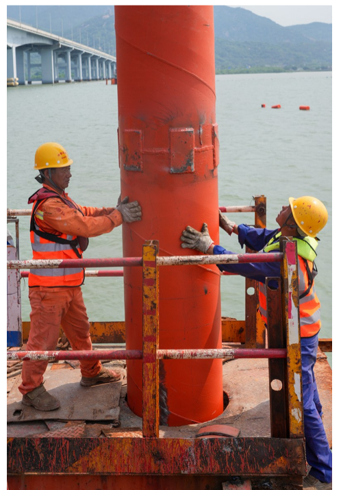
▲工人正在安装钢管桩
