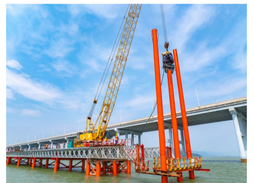
建设中的漳汕高铁漳江湾跨海特大桥
