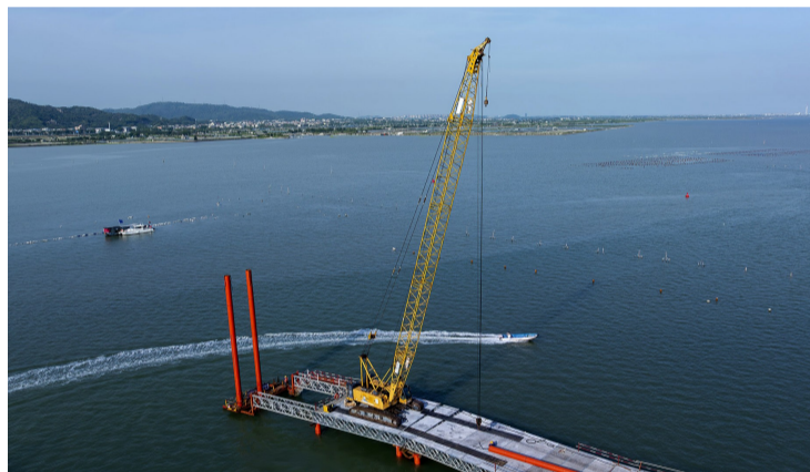
漳江湾跨海大桥栈桥基础钢管桩施工现场
