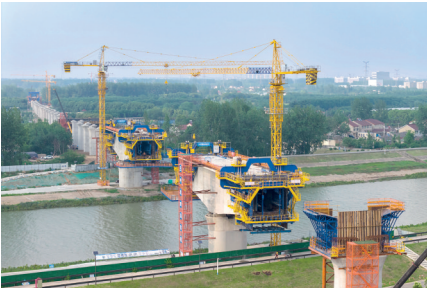
宁淮铁路马汉河大桥施工现场 王晓龙 摄
