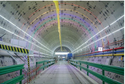
杭州萧山机场西隧道“启杭号”盾构机掘进施工 申琦 摄
