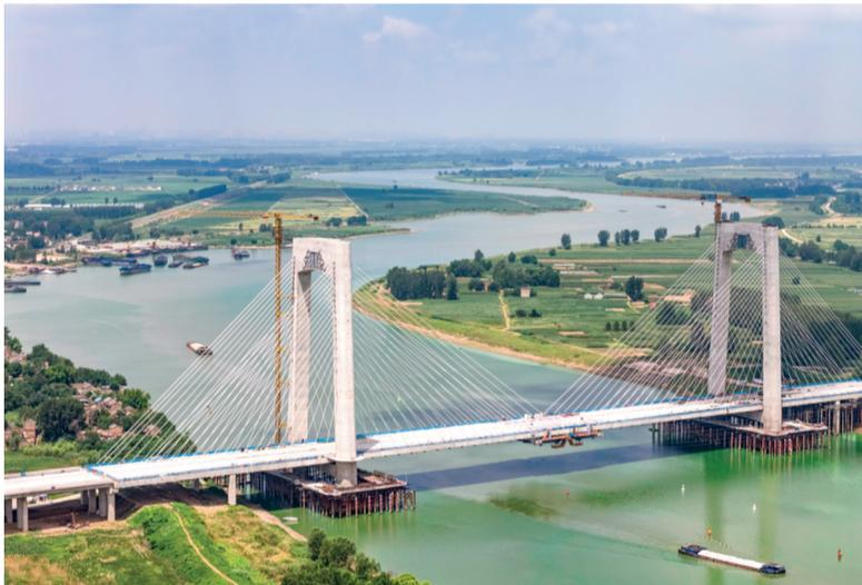
7月29日,中铁四局承建的G329凤阳至蚌埠改线工程01标段项目临淮关跨淮河特大桥梁主桥合龙。该项目线路全长29千米,临淮关跨淮河特大桥梁全长890米,主跨290米,钟型主塔高140.17米,设计为双塔双索面斜拉桥。
