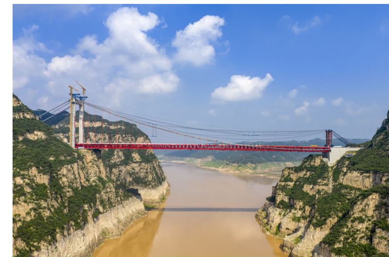
2025年7月31日,中铁四局承建的济新高速公路黄河大桥正式贯通。
