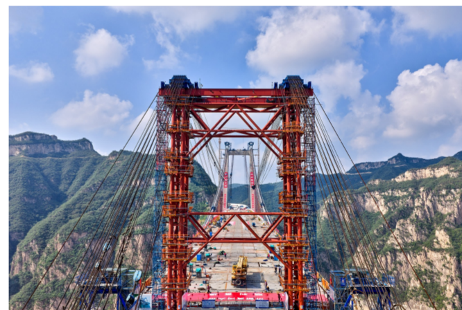
2025年7月31日,千丝万缕的钢索缠绕在塔柱之上,拉直了桥梁的脊背。
