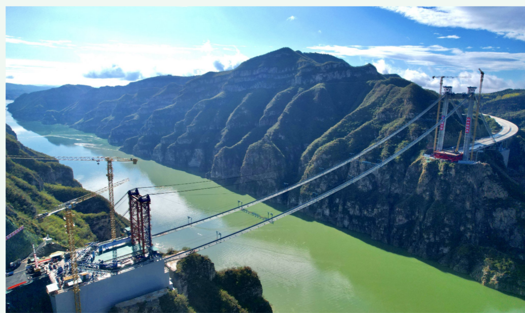
2024年6月17日,大桥猫道飞跃天堑,铺设完成。两条横跨南北的雄关漫道打通了关键作业线。
