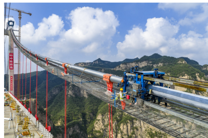
2025年7月30日,大桥主缆进行缠丝作业,这条撑起全桥的脊梁正在进行最后的升级。
