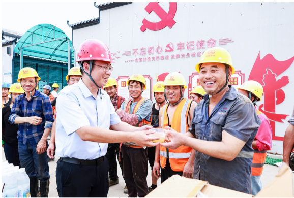
王海泉摄 城轨分公司天津地铁Z2线02标项目部为一线建设者送去清凉物资
