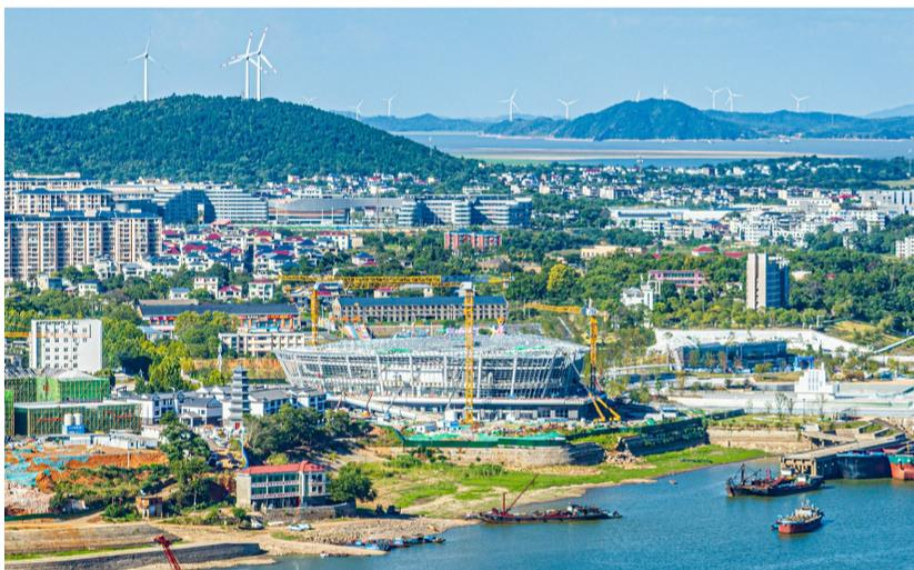
8月18日,中铁四局承建的庐山市全民健身中心项目施工现场一片火热。该项目位于原东船造船厂旧址,总建筑面积3.02万平方米,施工内容包括体育馆、全民健身中心、人防地下室、地下车库、设备用房等。目前,主体工程和网架工程已施工完成,正在进行金属屋面、幕墙、室内风水电安装等工序。
