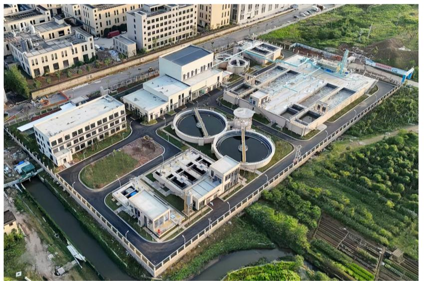
8月13日,中铁四局市政公司承建的衢州市龙游县城南污水处理厂工程(土建)项目通过竣工验收。该项目建成后可处理污水规模2万立方米/日,预计化学需氧量年削减量3285吨,悬浮物年削减量2847吨,总氮年削减量255.5吨,总磷年削减量25.55吨。该污水处理厂的建成对提高龙游县城南工业园区的城市基础设施水平、促进工农业生产可持续发展至关重要。
