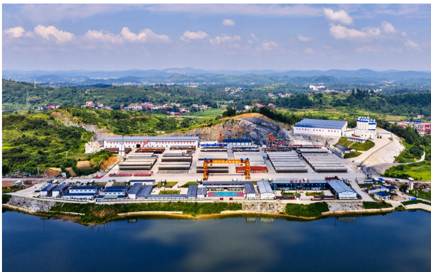
邵永高铁1标邵阳元塘制梁场
