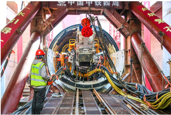
南宁邕江上游二期引水隧洞工程首台盾构始发
