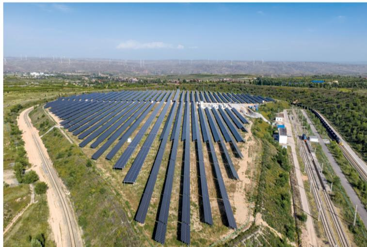
9月12日,中铁四局参建的华电煤业集团不连沟煤矿14.9988兆瓦分布式光伏电站竣工验收并投入运营。该项目利用煤矿铁路环线排土场310亩土地,采用尖顶式储物棚顶光伏安装模式,年均发电量2309.07万千瓦时,可满足矿区部分用电需求。
