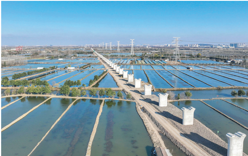
宁淮城际跨104国道特大桥成型墩柱
